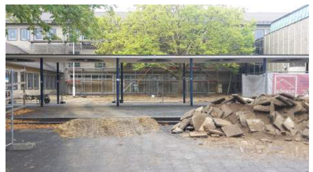
Arbeiten am Vorplatz des KWR
