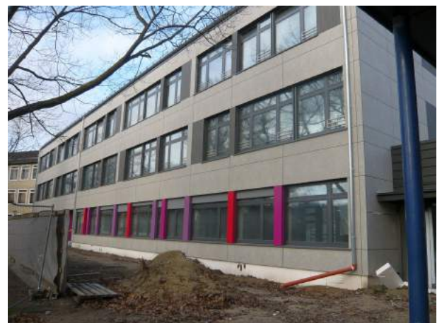
Fast fertig – unser neuer Schusterbau
